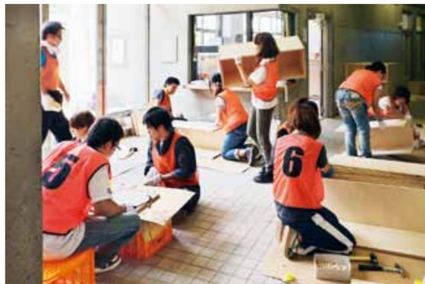
女川町に新たな被災者仮設住宅を建設。 建築・環境、プロダクトデザイン学科を中心にボランティアも。
