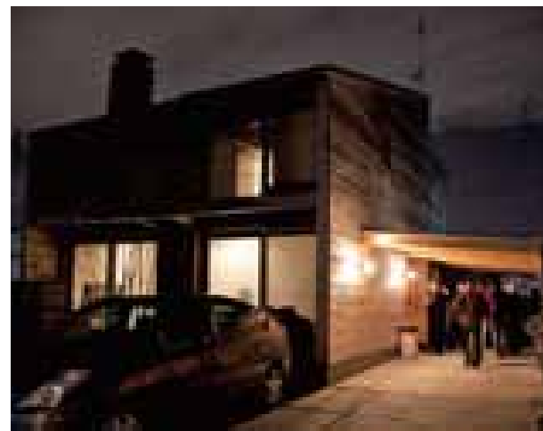
写真上:講座1日目、パッシブハウスの実例として、受講生全員で2011年夏に山形市内に完成した「house-m」を見学。通常の日本の住宅で使用するエネルギーのわずか10%の消費量でも快適に暮らせる家について、実際に住まわれている方からお話を伺いました。写真左下:「house-m」の外観。「山形の夜、外はもうこんなに寒いのに、室内は暖房を点けなくてもとても質のいい温かさでした」と九州からの受講生が驚いていたそうです。写真右下:講座2日目、森みわ講師の講義風景。この後に検定試験が控えていることもあり、受講生のみさんの表情は真剣そのものでした。
