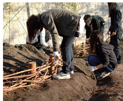
山形エコハウスの庭に施工した粗朶編み柵（左）と石敷きの暗渠（右）
