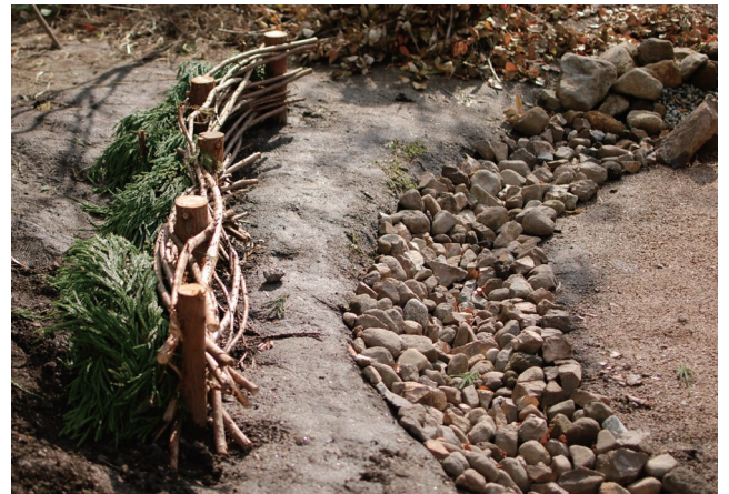
山形エコハウスの庭に施工した粗朶編み柵（左）と石敷きの暗渠（右）
