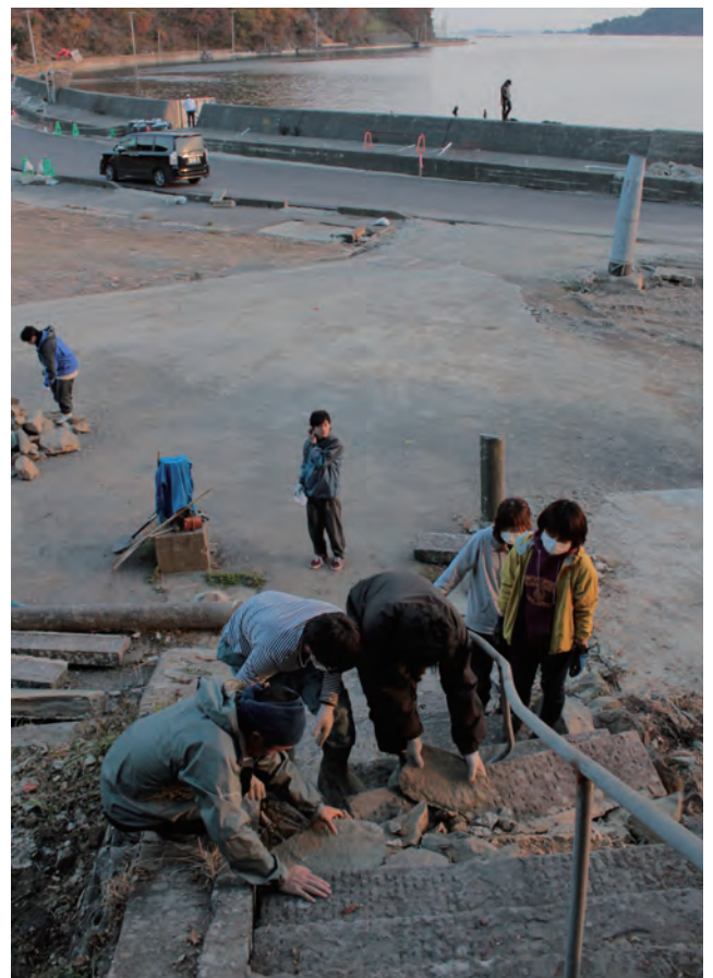
明神地区鹽竈神社の石段・石垣修復
