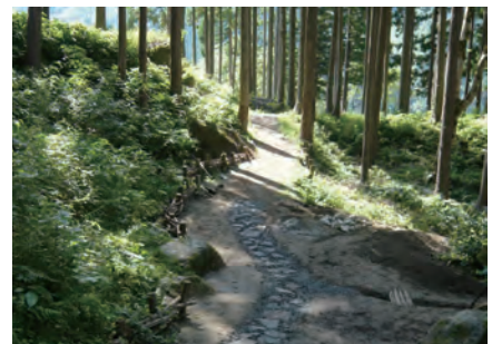
石を埋めて完成した道路兼暗渠
