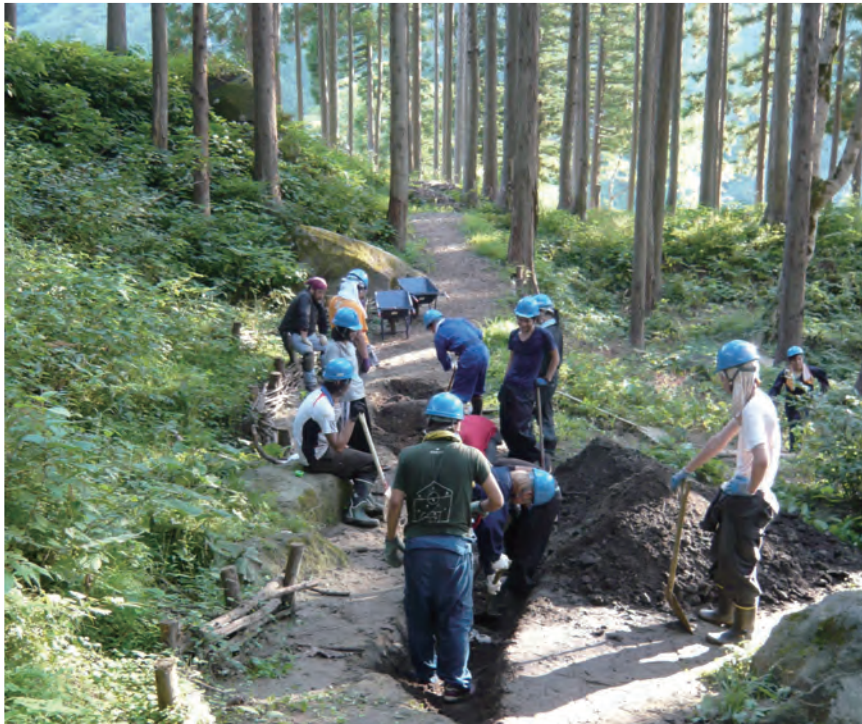
粘土に覆われた遊歩道中央部に排水工を施す様子
