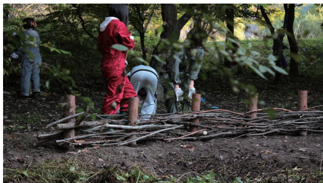
演習作業でつくった粗朶柵は散策路の結界と地形維持のための機能を果たす
