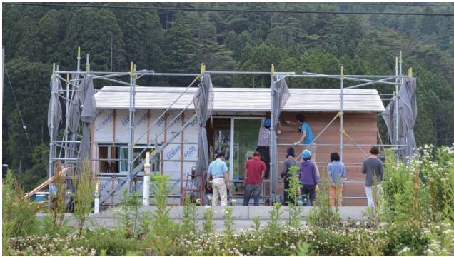
外壁工事を行う地元住民と学生たち
