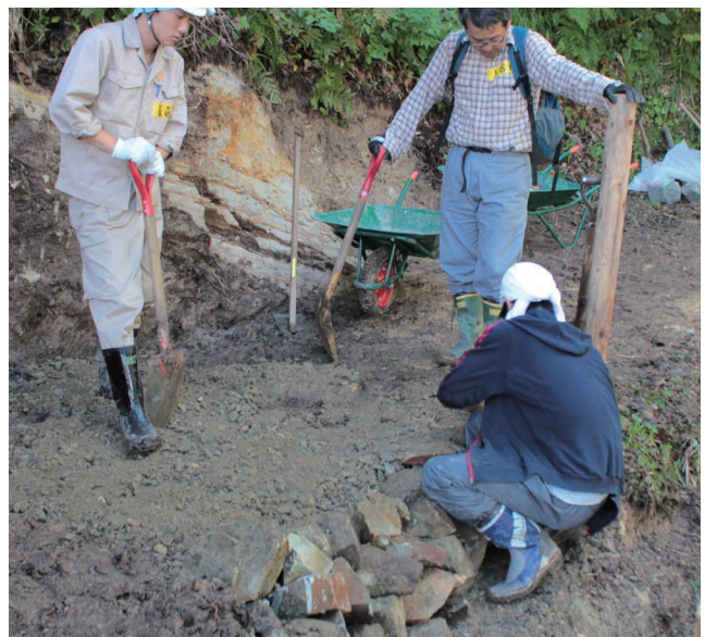
近自然工法の路肩形成。学生が県職員や地域住民と施工を行う
