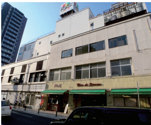
対象地2 ミツマスビル (外観)
