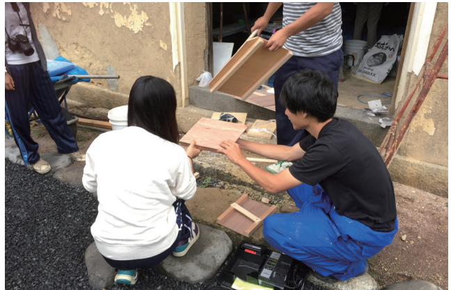
漆喰塗り作業の準備
