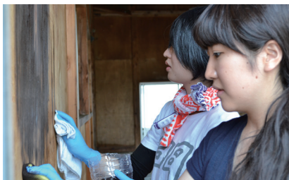
柿渋塗装の施工
