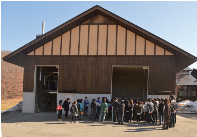
シューネスハイムのバイオマスボイラー上屋
