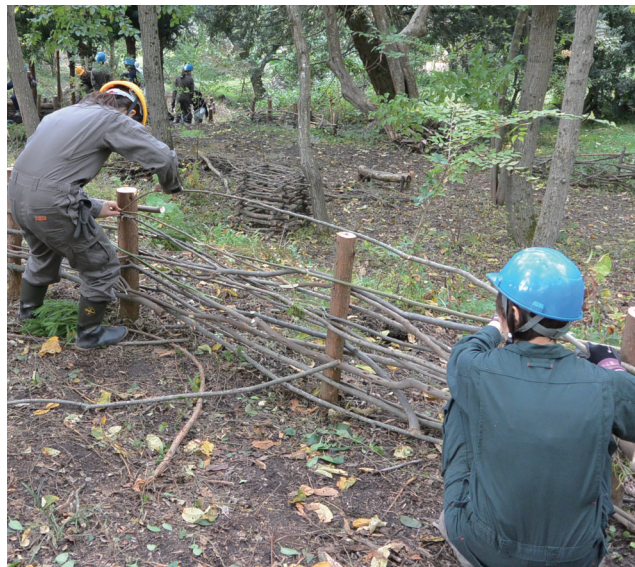
粗朶柵（そださく）の施工
