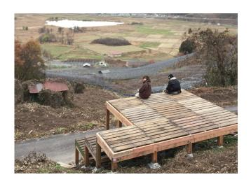
赤湯十分一山 環境ツーリズムプロジェクト/十分一山テラス製作 山形県南陽市の十分一山は、南向き斜面を活かしたぶどうの産 地として知られている。自然と農業とが長年にわたって形成してきた美しい風景を保全するため、2009年度より「環境ツーリズムプロジェクト」を実践している。2017年度は、恒常的な活動の拠点とするため「十分一山テラス」をセルフビルドで製作。防腐木材を使用した軸組の上に、近所のホームセンターで提供いただいた重量物用パレットを床として敷設した。今後、この場所を活かした活動を継続する予定である。(西澤高男)
