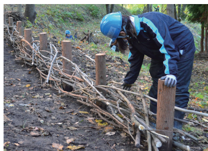
スギの支柱と広葉樹の枝で粗朶柵をつくる
