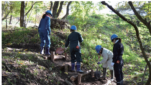
自ら調達したスギ間伐材で小階段をつくる
