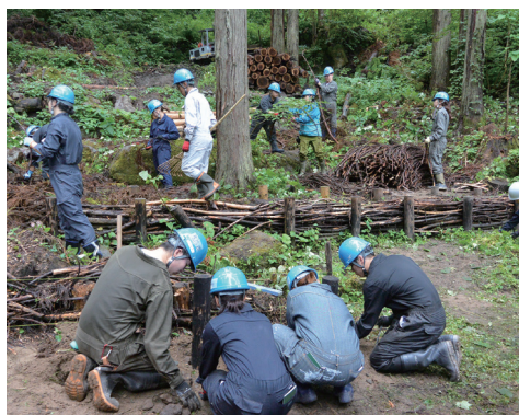
スギの人工林と一体となった空間整備
