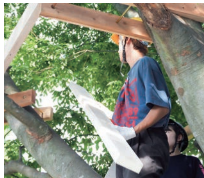
土台を慎重に組み立てていく
