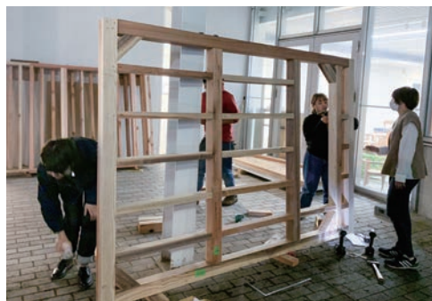
学生たちによるサウナ小屋の施工風景
